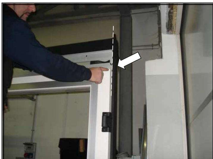
1.5.2 Verificare la planarità del binario utilizzando una livella a bolla d'aria.
